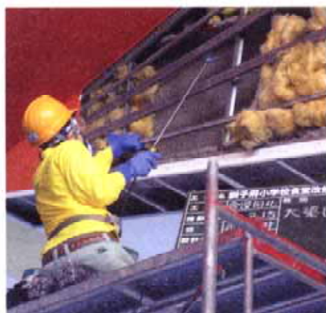
エコ・24は吹き付け材にシリコンを主成分とする固化剤を浸透させて、アスベスト繊維(上)を太くして無害化する(下)技術を開発した
