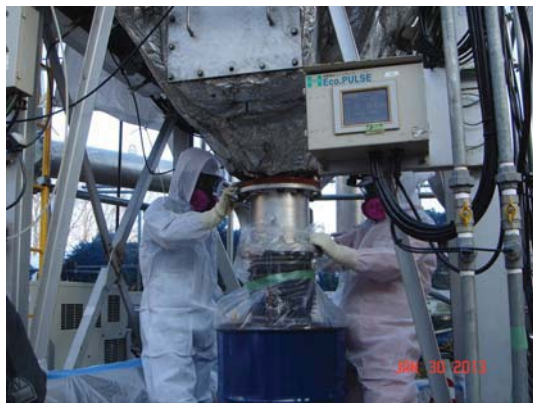
バグフィルタからの溶融飛灰回収作業
