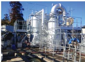
エマルジョンバーナー式表面溶融炉NK-500(処理能力:500kg/h)
